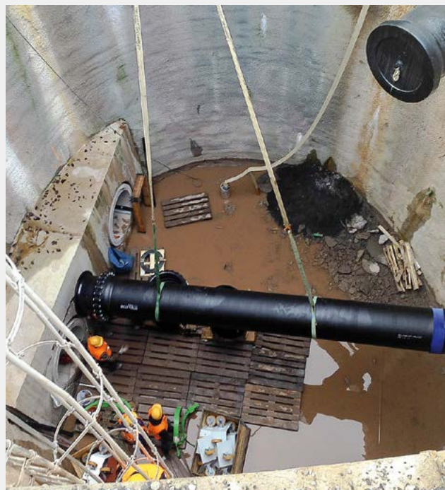
Fig. 7 Conduite double de DN 700 dans le puits (microtunnel en béton) Doppelleitung DN 700 im Schacht (Microtunnel aus Beton)
