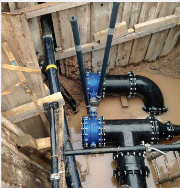
Fig. 6 Branchements et vanne papillon vonRoll DN 400 Abgänge und vonRoll -Absperrklappen DN 400
