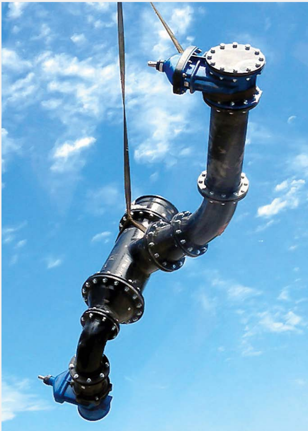
Fig. 10 Ensemble pré-monté transporté par hélicoptère Mit dem Helikopter eingeflogene vormontierte Seitenanschlüsse mit Schieber (Baugruppe)
