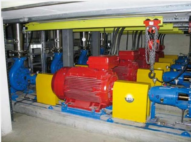
Fig. 3 Station de pompage de 5 fois 700 m<sup>3</sup>/h (Source: SIG)
