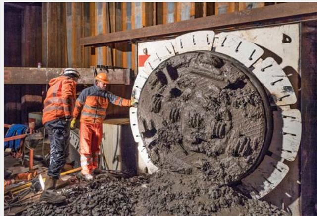
Fig. 5 Nach 357 Meter erreichte am 17. Januar 2018 der Bohrkopf den Zielschacht beim See. Danach wurde er aus dem Schacht gekrant und für den nächsten Leitungsabschnitt vorbereitet.
