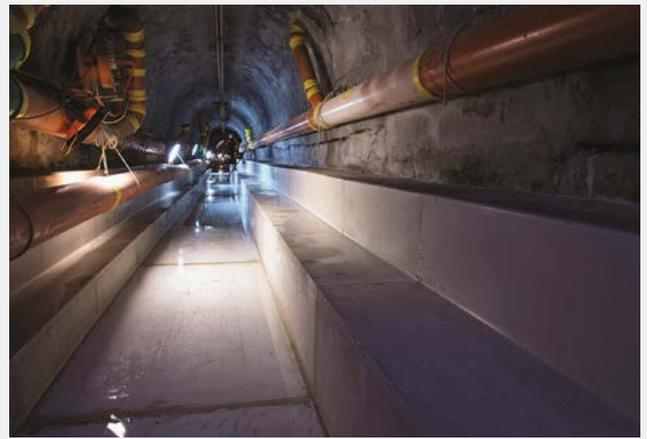
Fig. 4 Wärmegewinnung aus dem Abwasserkanal am Beispiel Hirschgraben in der Stadt Luzern
