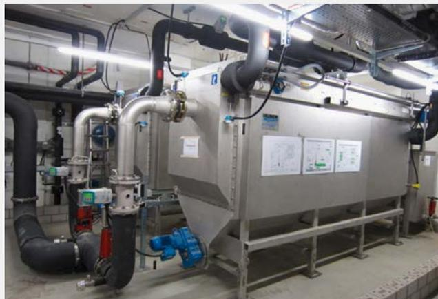
Fig. 5 Wärmetauscher ausserhalb des Kanals beim Wintower in Winterthur von Picatech Huber AG
