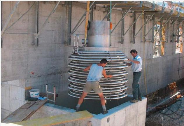
Fig. 3 Einbau der Wärmetauscher in den Schacht einer Wohnüberbauung zur Abwasserwärmerückgewinnung im eigenen Gebäude
